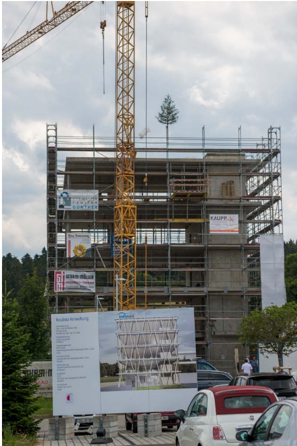
Bild 1: Rohbau des neuen Verwaltungsgebäudes (rohbau.jpg)
